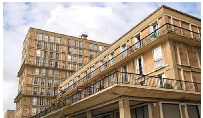
Zeitlose Architektur von Auguste Perret. Getönter Beton verleiht den Gebäuden je nach Wetter und Tageszeit wechselnde Nuancen
