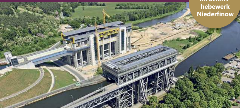
Neues und altes Schiffshebewerk Niederfinow
